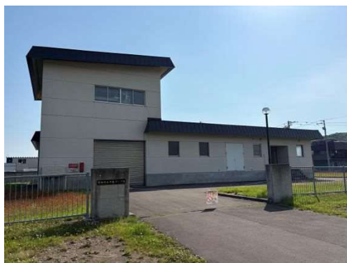
鷹栖汚水中継ポンプ場
