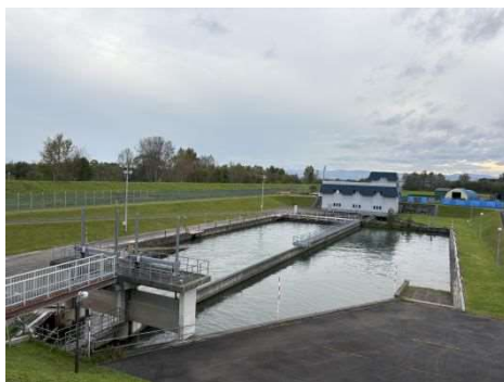
永山取水施設
