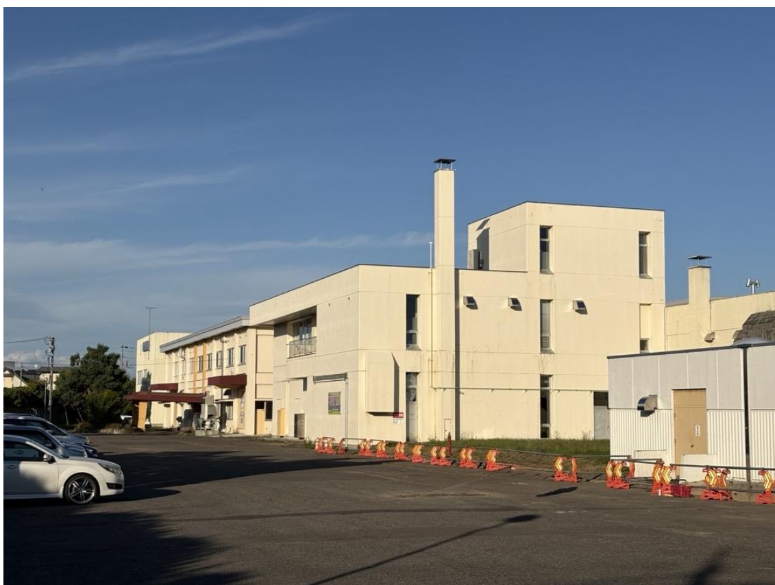
図表6 石狩川浄水場
