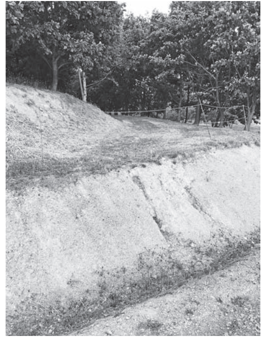
寸断されていたパレットヒルズの道路 事故後、崖をなだらかにするなど再発防止の対策を行なっています
