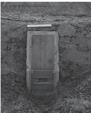
北野地区で設置されている遮へい板
