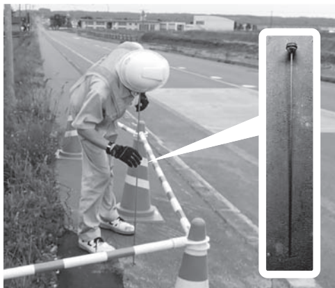
音聴棒による漏水調査の様子 水道管が老朽化すると漏水しやすくなります
