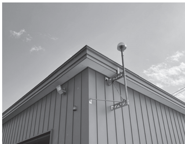
あったかファームに設置された自動操舵のためのアンテナ
