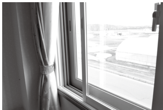
▲ 補助金を活用して改修された窓
