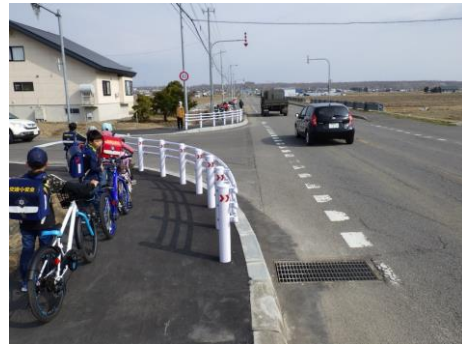
道道旭川幌加内線 (ガードパイプ)
