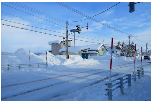
小学校前：道道旭川幌加内線 (ガードパイプ)
