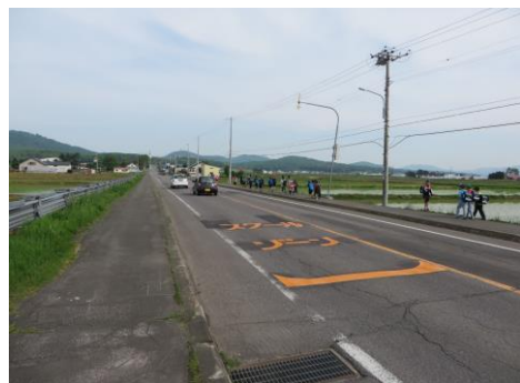
道道旭川幌加内線（路面標示）
