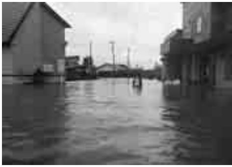
高さ1メートルほどまで冠水した北野東5条1丁目
