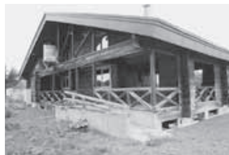
▲旧ロッキールاندのログハウス外観
