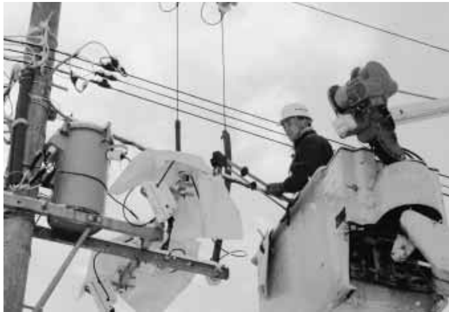
無停電間接工法を可能にする「ホットスティック」を、熟練した手さばきで操る川上さん。
