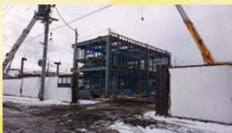
建設中のサービス付き高齢者向け住宅
