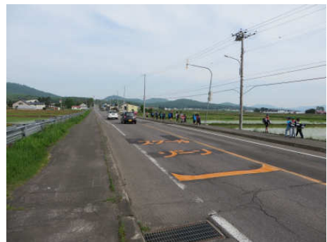
道道旭川幌加内線（路面標示）
