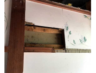
④ 撤去完了
