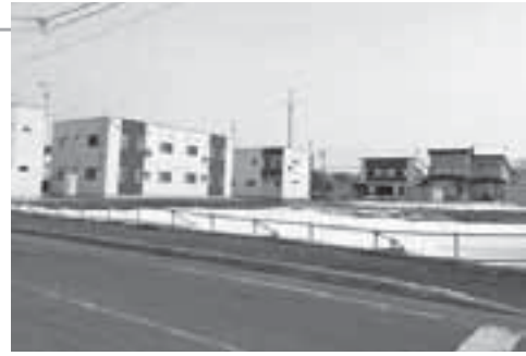
未着工の現場
